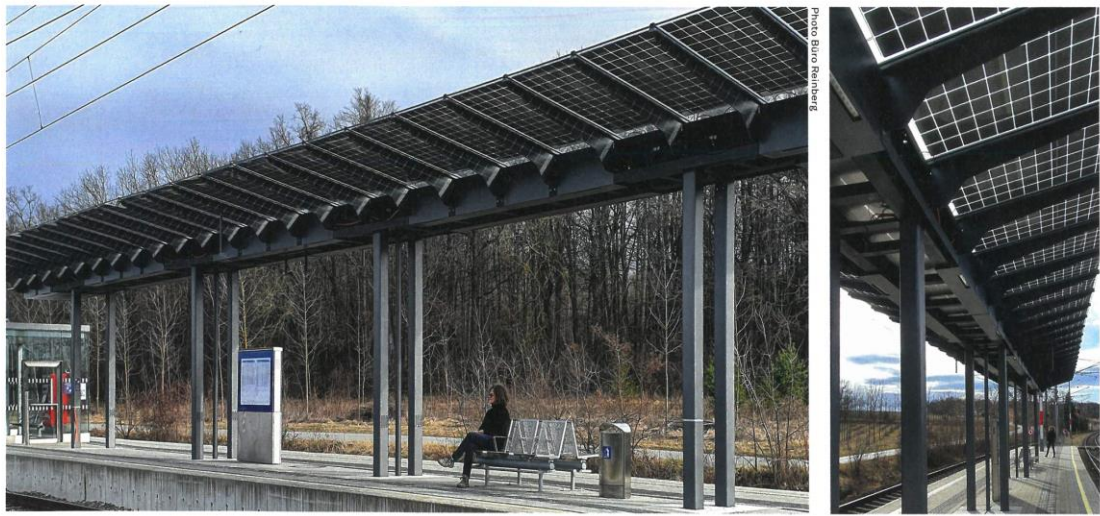
Aus einem Forschungsprojekt hervorgegangen und sogleich ausgerollt... Resulting from a research project and rolled out soon... ...PV-Dächer in Sierndorf/NÖ. ...PV-roofs.
